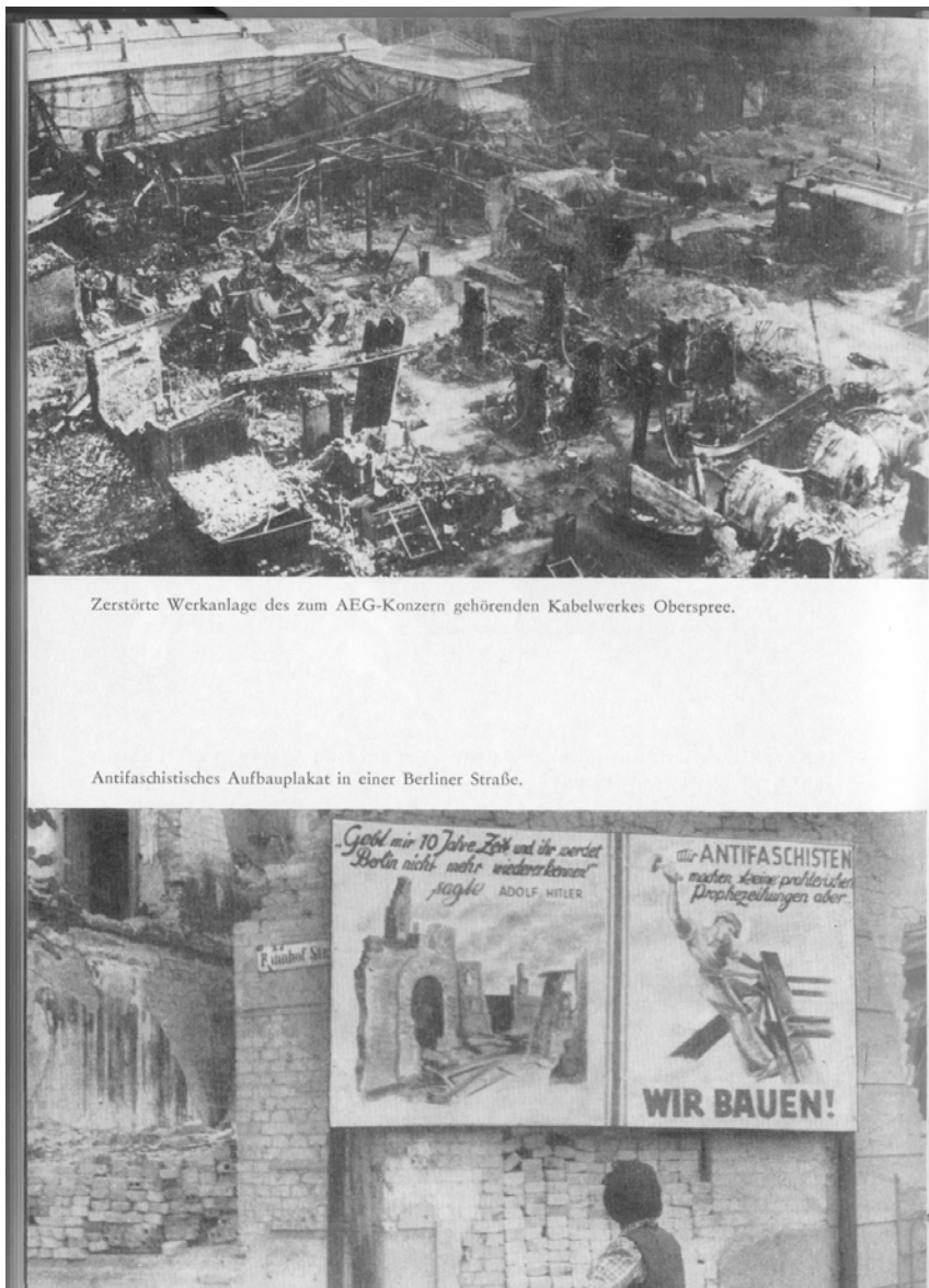
Abb. 37: Zerstörte Werksanlage des Kabelwerkes Oberspree Antifaschistisches Aufbauplakat in der Berliner Straße
