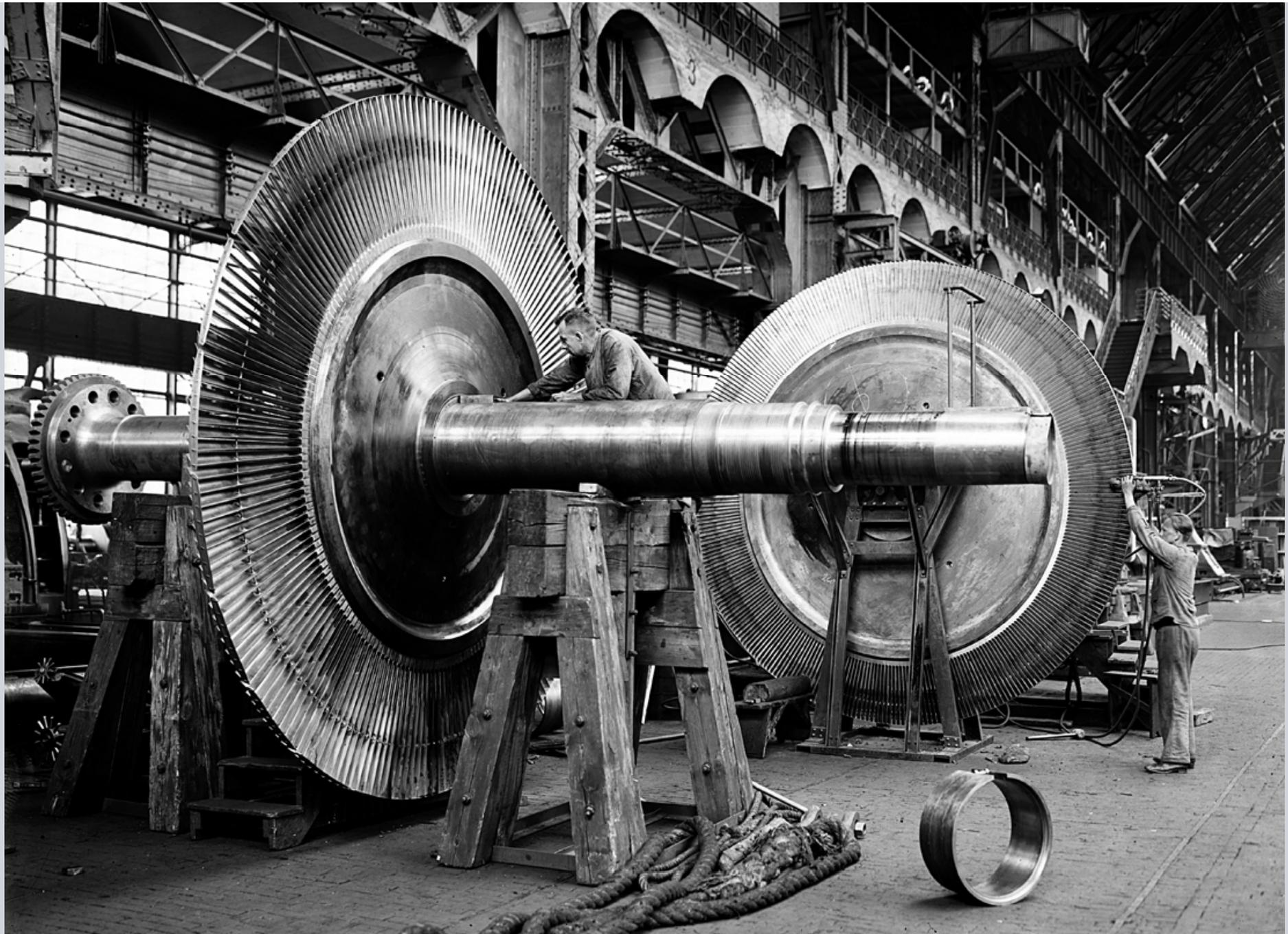
Montage eines Dampfturbinenläufers, 1930
