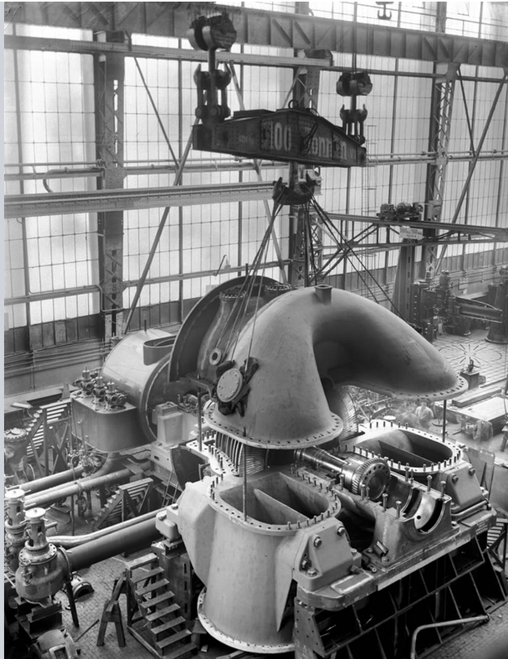
Endmontage einer Niederdruckdampfturbine, 1930
