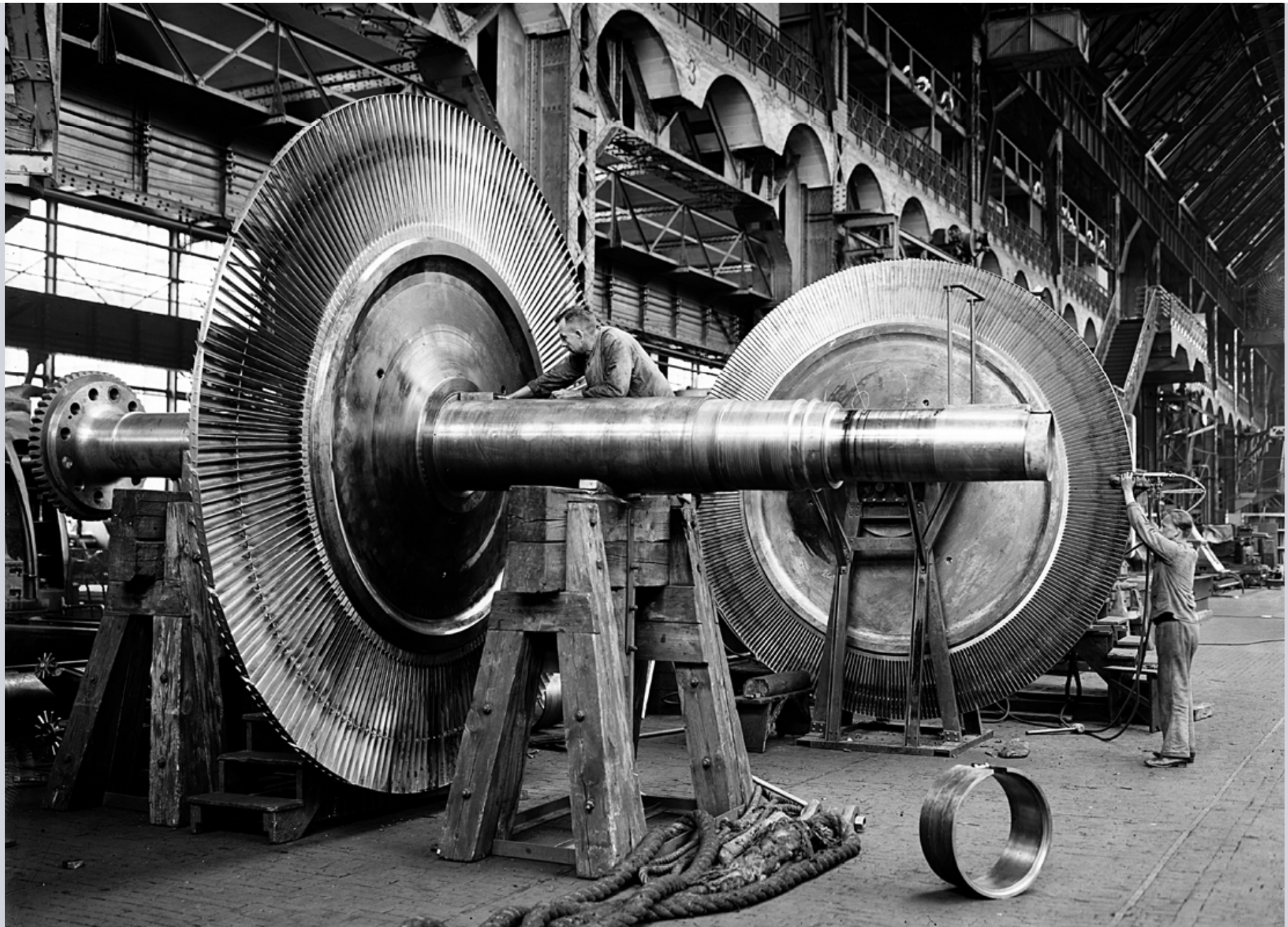
Montage eines Dampfturbinenläufers, 1930
