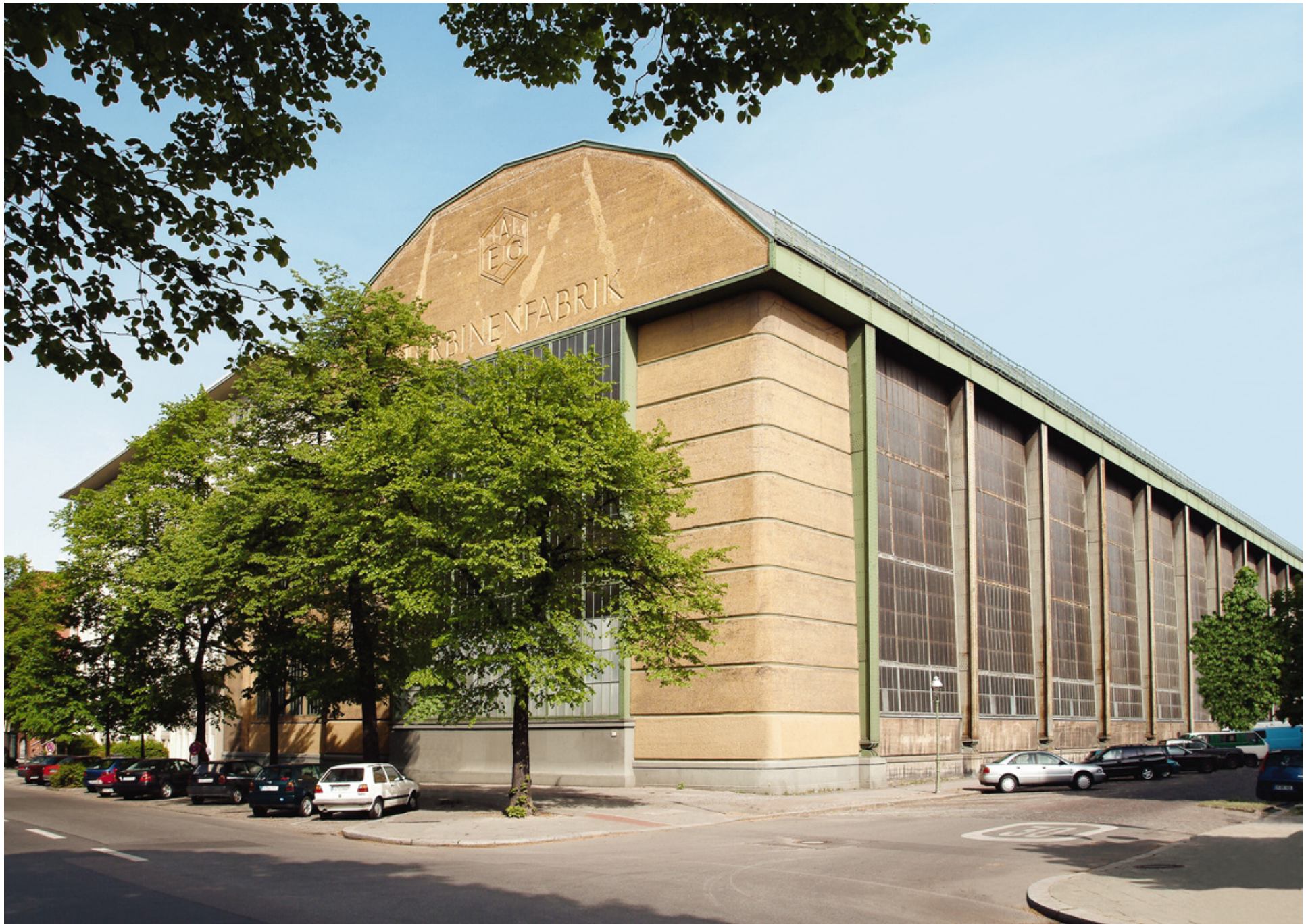
Siemens Gasturbinenwerk Berlin; Außenansicht der Peter-Behrens-Halle 2003
