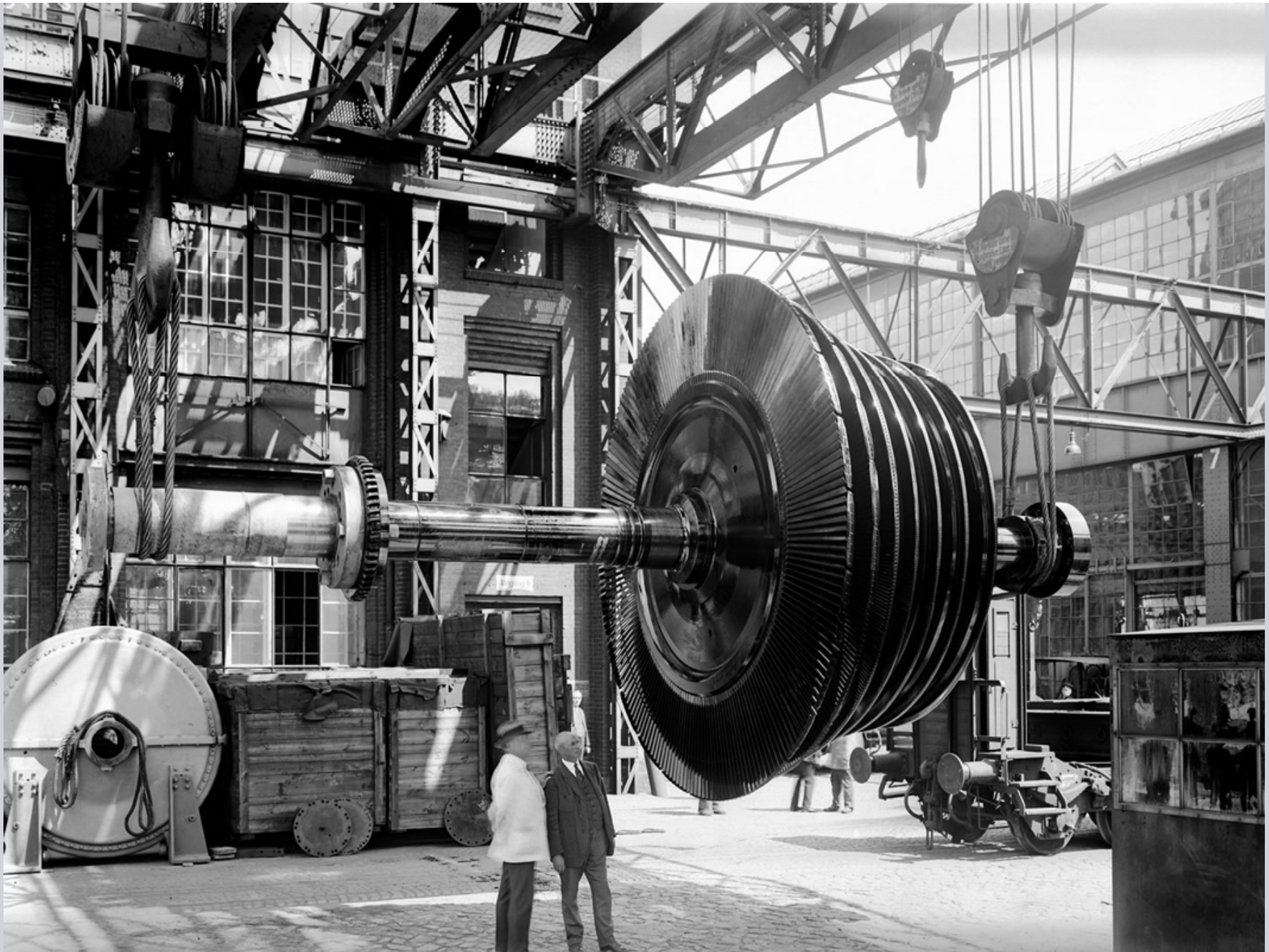
Transport eines Dampfturbinenläufers, 1930
